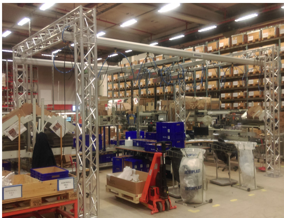
Skensystem med 2st enkeltraverser placerat i 2st. Trossbågar.
